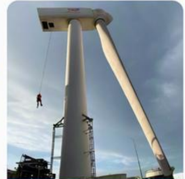
Travaux en hauteur
