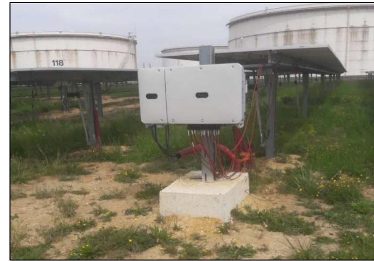
Onduleur HUAWEI avec interrupteurs-sectionneurs (en dessous)
