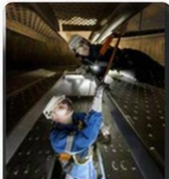
Travaux en espaces confinés
