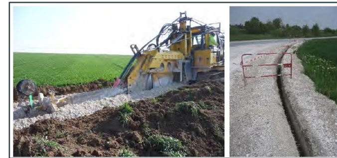
Exemple de tranchée réalisée (Source : TotalEnergies)
