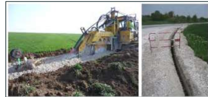
Exemple de tranchée réalisée (Source : TotalEnergies)
