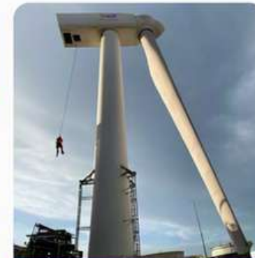
Travaux en hauteur
