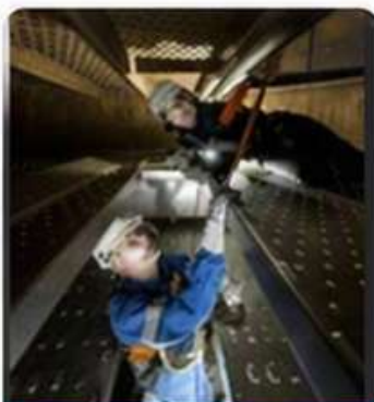
Travaux en espaces confinés
