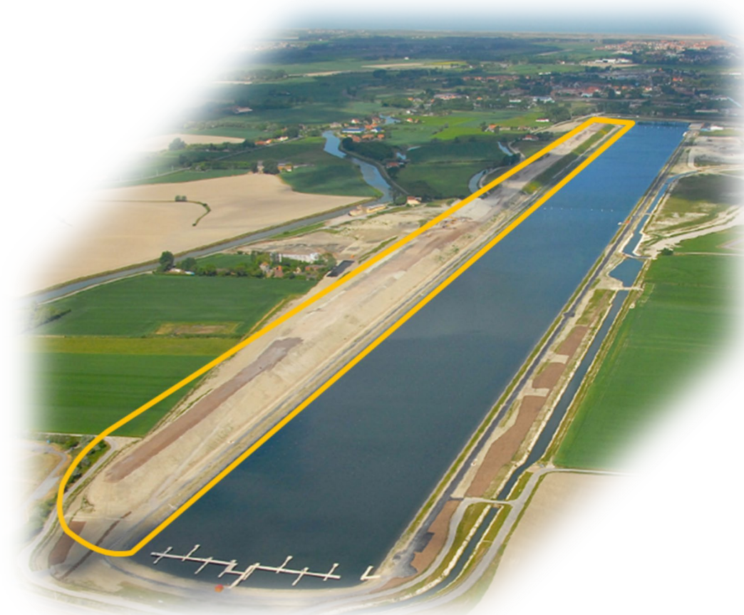
2012 - Butte coupe vent constituée en laitier LD Bassin d'aviron – ville de Gravelines 59
